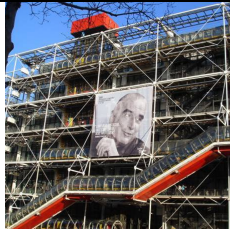
le Centre Pompidou
