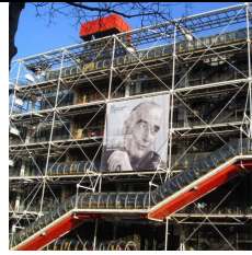
le Centre Pompidou
